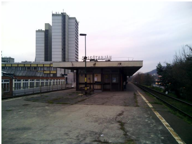
44. ábra Salgótarjáni belvárosi vasútállomás
